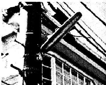
既存街路灯（蛍光灯20W） （約70cm）
