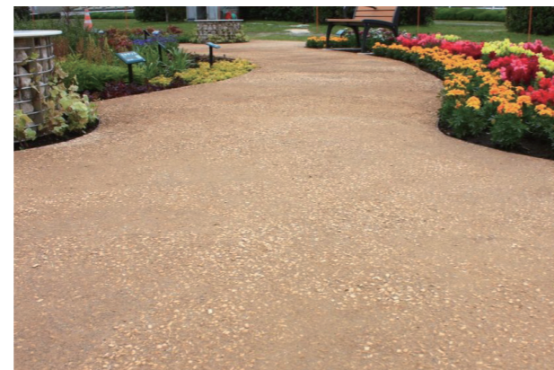
硬化土舗装（間伐材ウッドチップ舗装）イメージ
