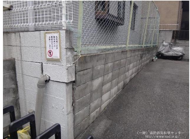
写真 (左) 平成28年熊本地震により倒れたブロック塀
