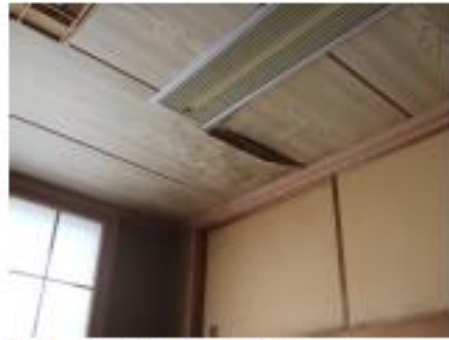
●天井・内壁：漏水の痕跡
