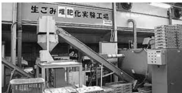
生ごみ堆肥化実験工場
