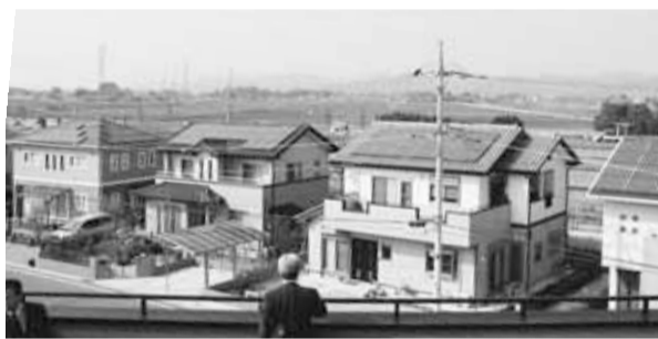
屋根に太陽電池パネルが設置された「パルタウン城西の杜」
