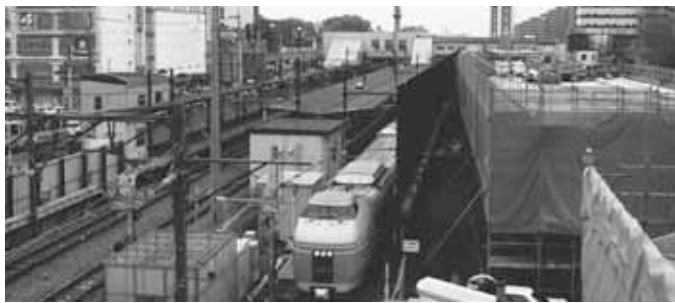
高架工事が進むJR中央本線
