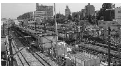
高架化工事が進む武蔵小金井駅周辺
