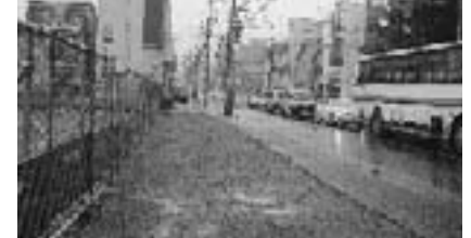
拡幅工事のすすむ小金井街道
