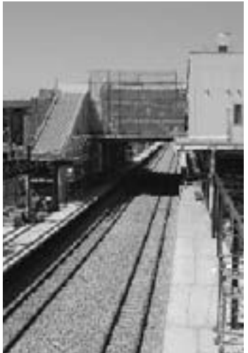
仮線工事で生まれ変わる武蔵小金井駅
