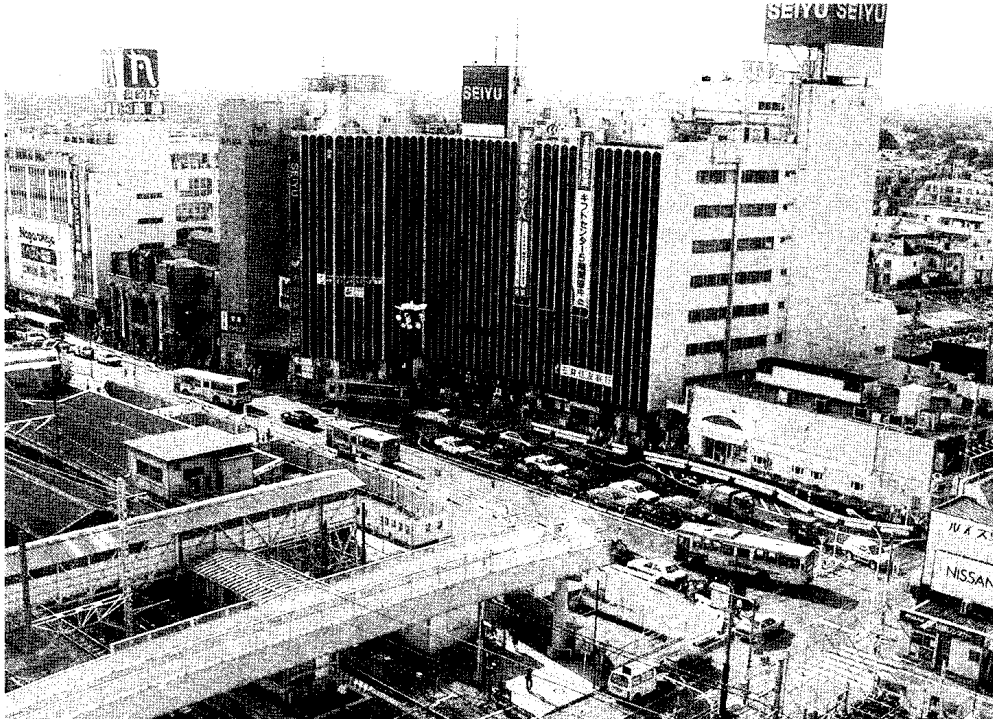
中央線高架化事業が着工となり駅前も様変わり(武蔵小金井駅北口)
