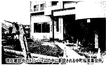
現在建設中のトミン・ハイムの中に新設される中町桜並集会所
