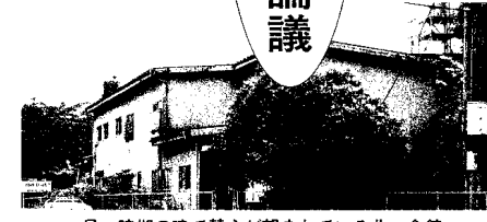
早い時期の建て替えが望まれている北一會館
