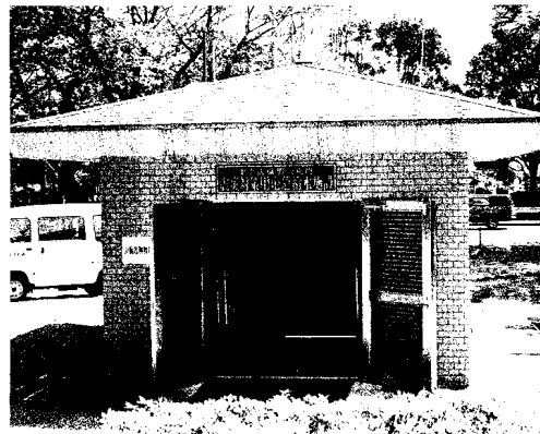
災害時の飲料水の確保を(武蔵野公園内応急給水槽)
