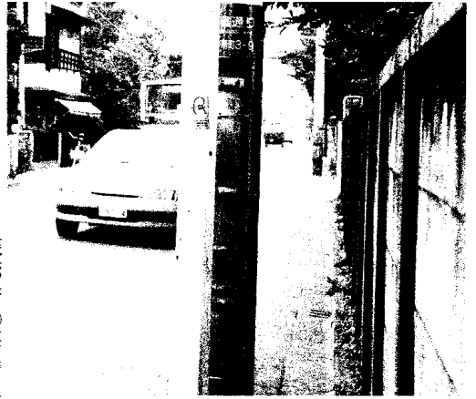
歩行者に危険な電柱と万年塀の改善が望まれている
