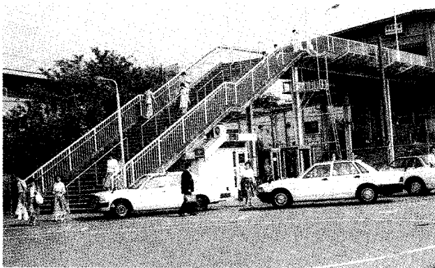
東小金井駅階段に屋根を設置するための予算が計上された
