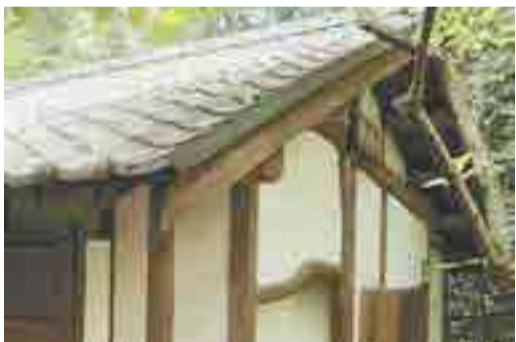
古材転用の柱・梁
