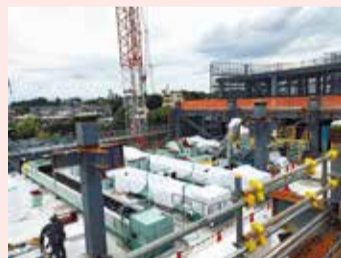
3階コンベヤ設置の様子
