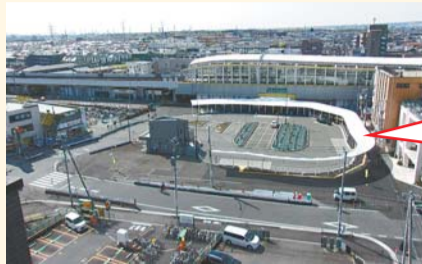
▲東小金井駅北口交通広場
