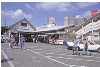
JR武蔵小金井駅南口(平成2年)
