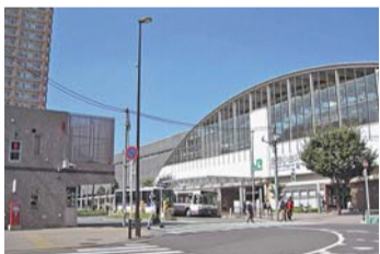
JR武蔵小金井駅南口(平成29年)
