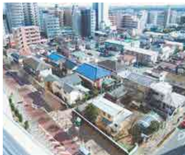
工事着手前(平成29年2月)
