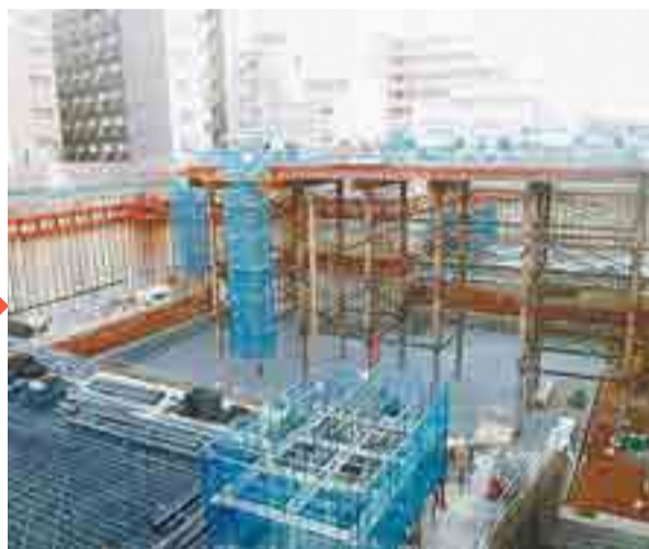
土の掘削と基礎工事(平成30年1月)
