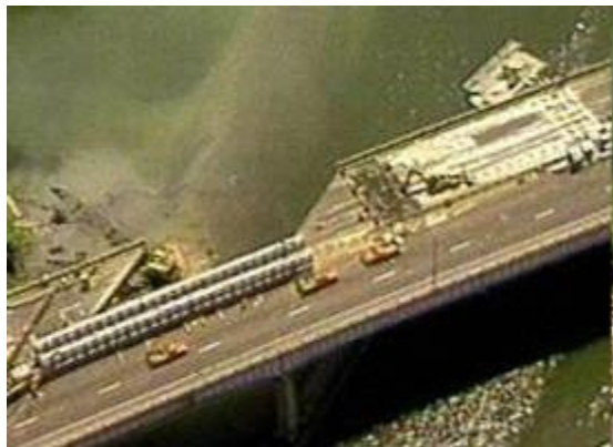
写真-1 マイアナス橋の落橋 写真-2 I-35W橋の落橋（ミネアポリス橋りょう） （国立研究開発法人 土木研究所 構造物メンテナンス研究センターHPより）
