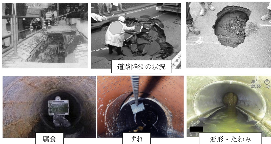
図 2-6 下水道管渠の劣化事例
