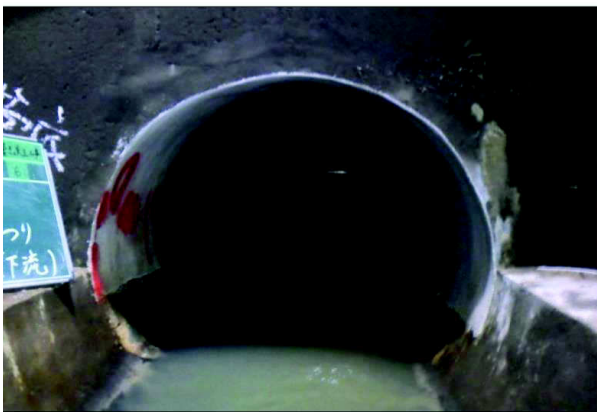
3 管更生施工前(製管工法)
