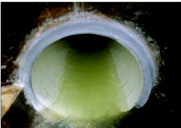
5 製管及び裏込め完了
