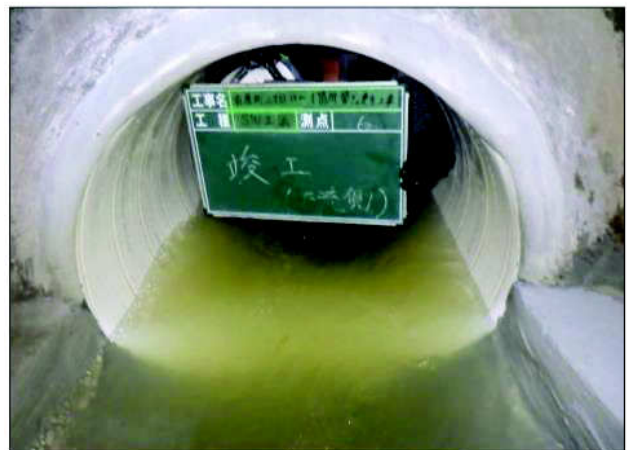
6 管更生(製管工法)完了
