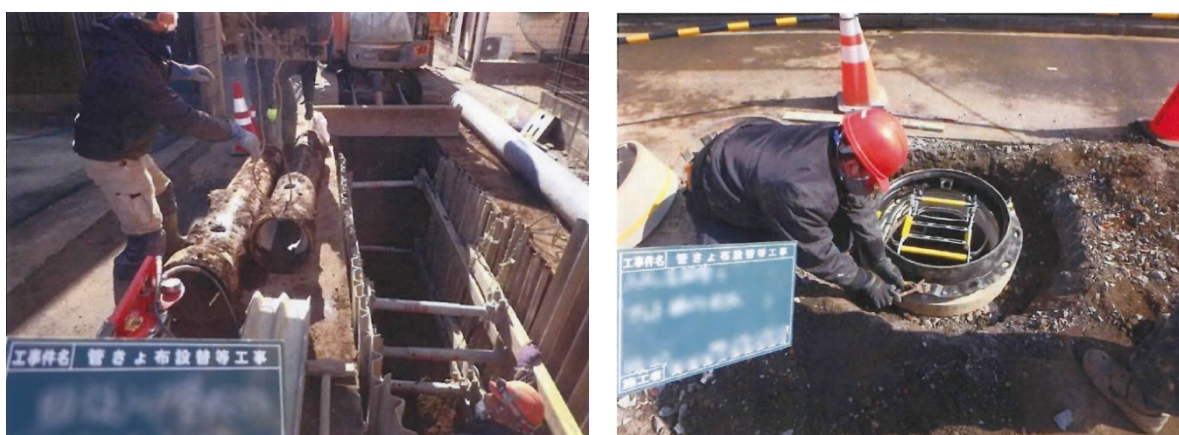
図4-4 管路・マンホールの修繕・改築
