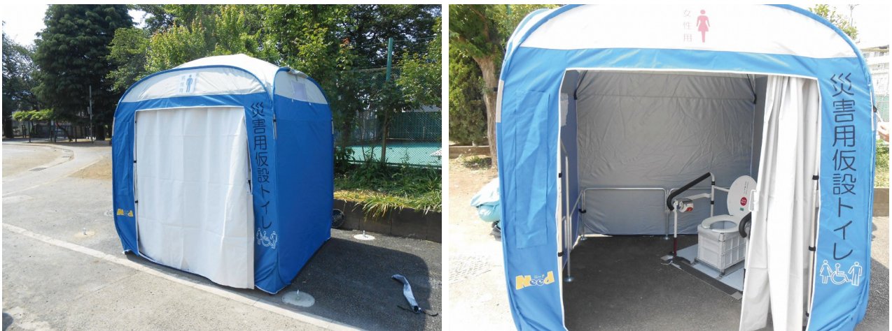
図3-8 マンホールトイレ写真
