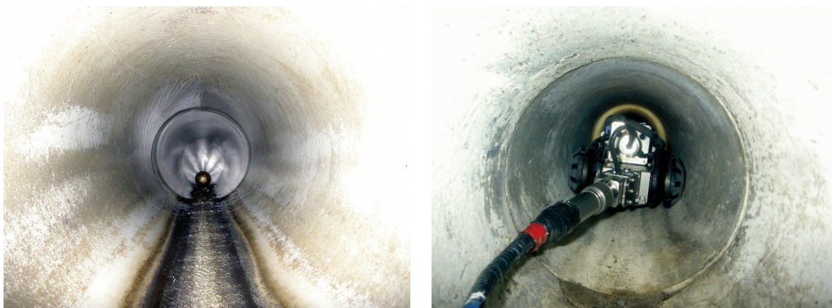
図4-3 管路カメラ調査
