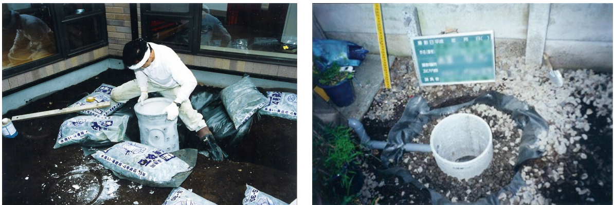
図 4-7 雨水浸透ます設置工事
