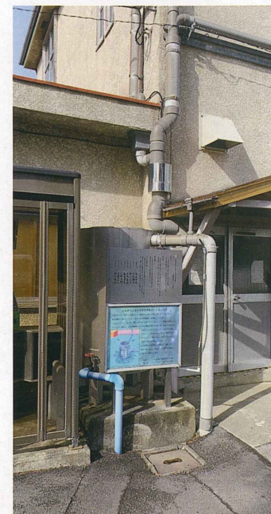
小金井市役所西庁舎に設置している「雨水貯留・浸透体験施設」
