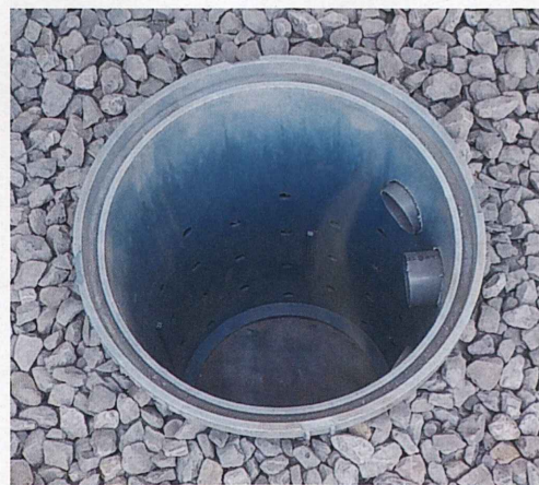
「雨水浸透ます」設置状態
