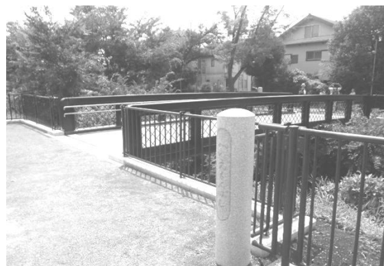
人道橋（平右衛門橋）の設置
