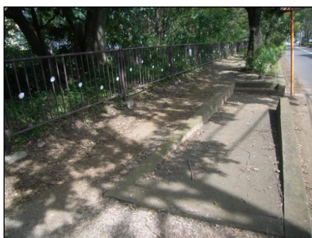
写真12 既設の階段とスロープ
