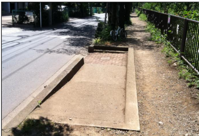
写真 14 既設の階段とスロープ
