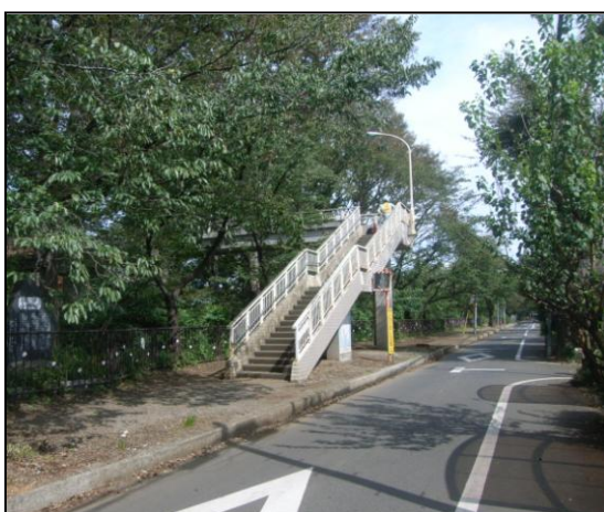
写真11 既設の歩道橋
