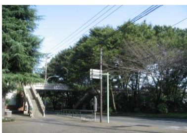
写真 17 公園入口より歩道橋を眺望
