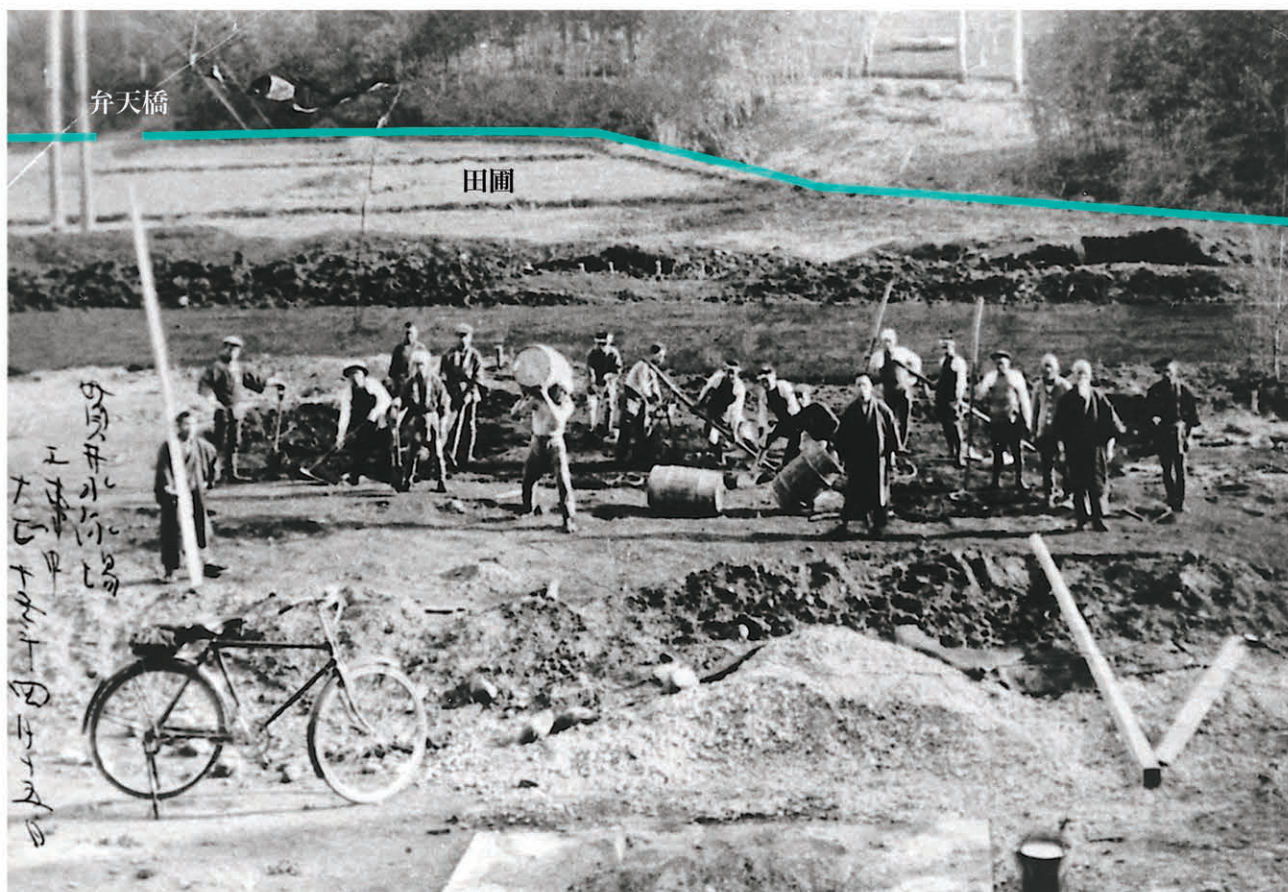
貫井プールを工事する青年会 大正 12 年（1923）4 月 15 日
